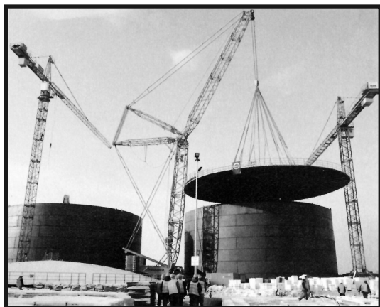
Prangl použil 600tunový jeřáb s příhradovým ramenem ke zdvihu střešní části v Göny, kombinované cyklické elektrárně v Maďarsku
