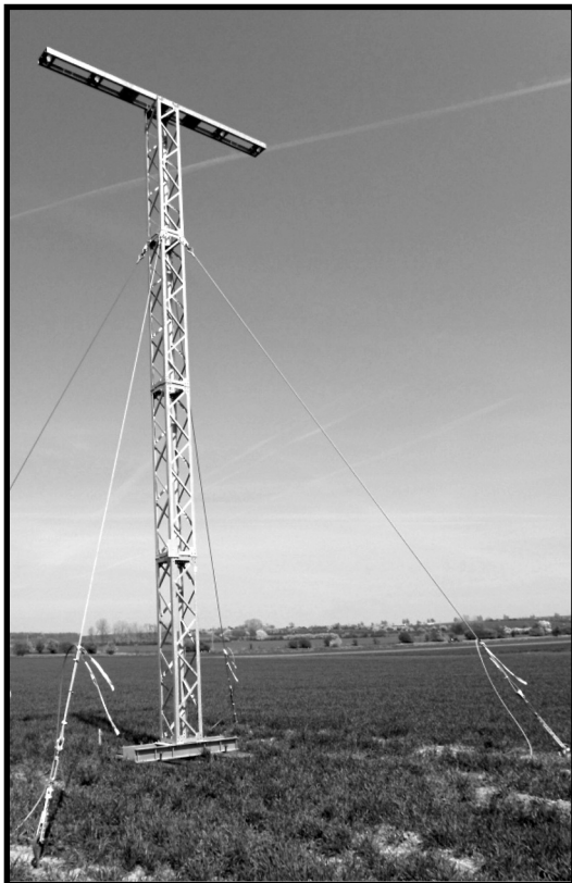
Pohled na sloup provizorního vedení
