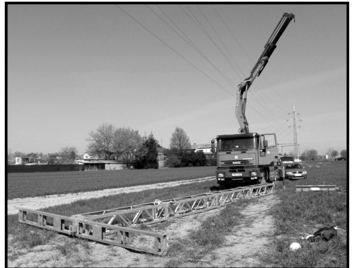
Nakládací jeřáb po pádu sloupu
