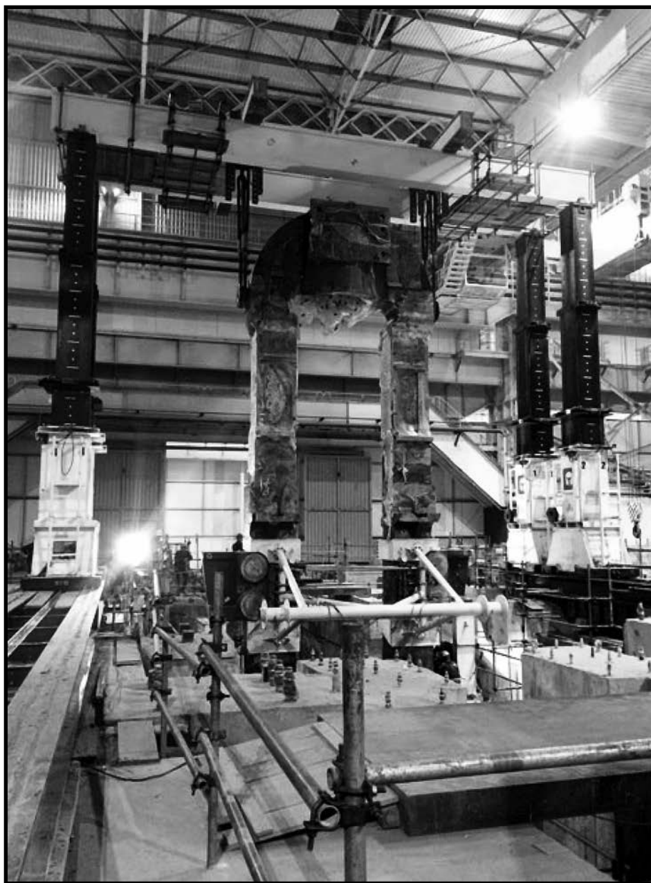
Součást stoličky se před instalací složitě otáčí
