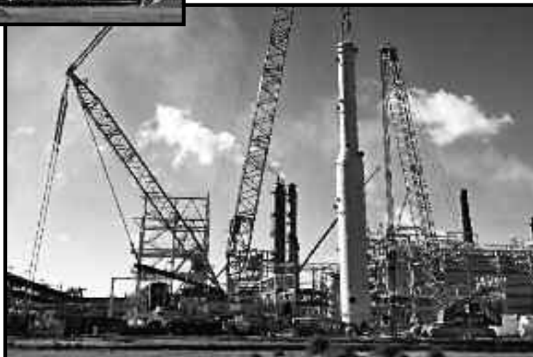
7) Břemeno ve vertikální poloze, LR1350.1 odepnut. Celá zdvih přebírá CC6800:
