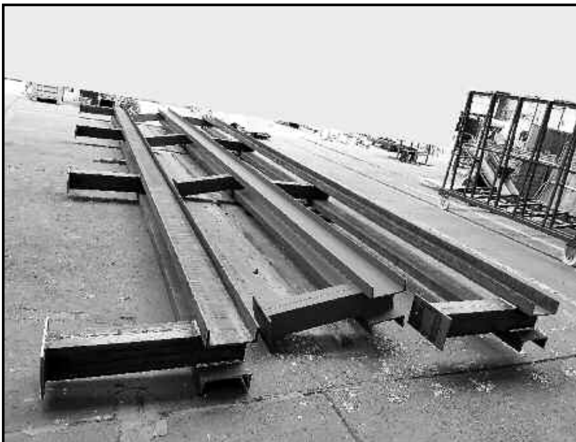
pracoviště montážní haly společnosti „X“ – pohled na tři položené podpěrné konstrukce
