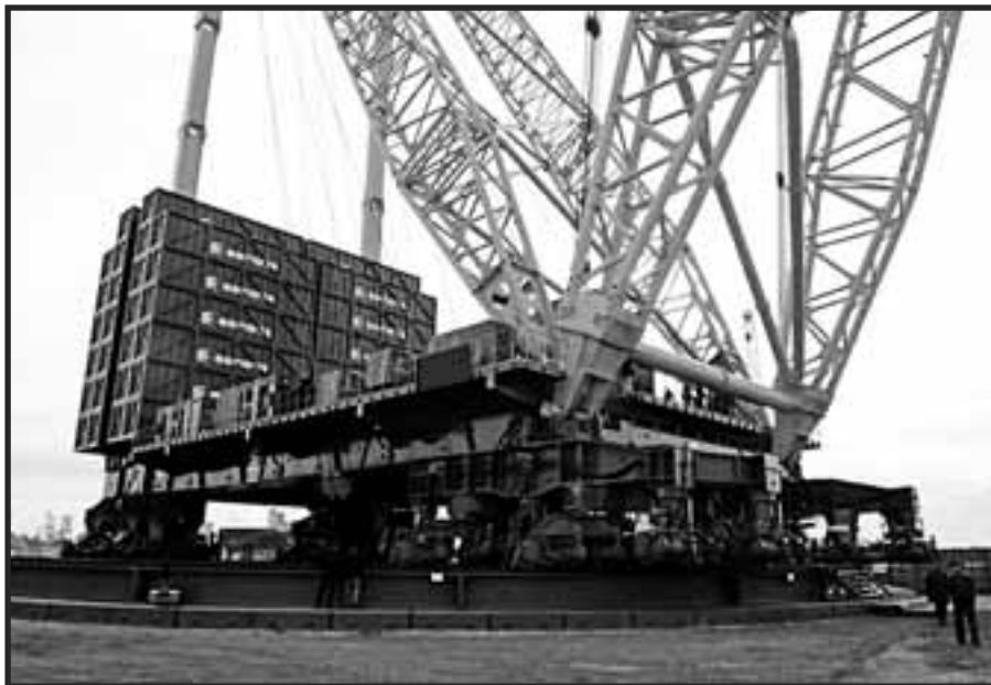
Jeřáb váží 9000tun, z toho je 5000tun protizávaží
