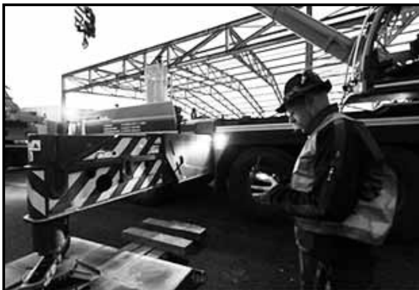
Podpěry na LTM 1300-6.2 jsou vysunuty
