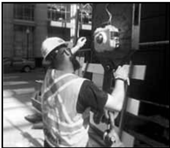
Vazač připevňuje pomocí magnetu zařízení HoistCam na kladnici jeřábu
