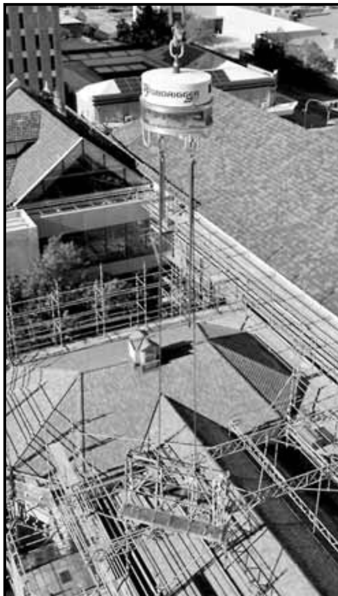
Zařízení Roberigger od společnosti Tensa, která díky tomuto zařízení vyhrála Australskou cenu za bezpečnost práce.
