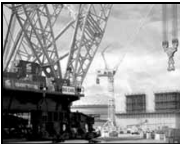
SGC-250 zvedá součásti jaderného reaktoru
