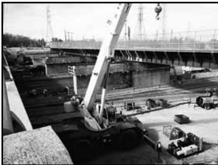
SmartJack od Společnost Buckingham Equipment Systém na projektu v Tennessee
