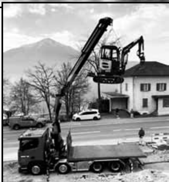
Palfinger PK 37.002 TEC 7 přiváží techniku pro společnost Rust + Co
