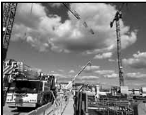
AMCS's DCS 61-S byl použit při stavbě metra v Les Ardoines ve Francii.
